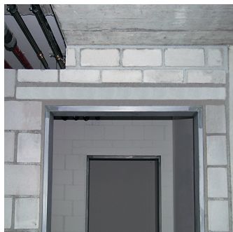
Linteaux en béton
