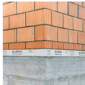
Éléments de base de mur
